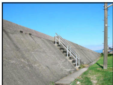
白岩川河口の堤防(この上で観測)
