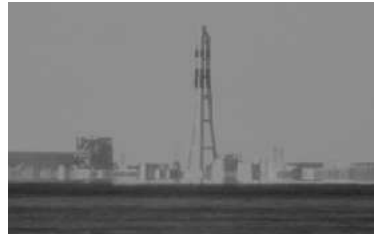
図6 富山火力発電所(下位)
